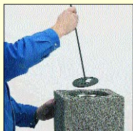
4.7 Vyhladit vyhlazovačem spar spoj vložek (pohybem nahoru dolů).
