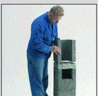
I.6 Ověřenou tvárnici osadit do maltového lože na soklové desce, nanést na horní plochu tenkovrstvou maltu.
