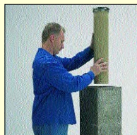
4.6 Osadit další profilovanou vložku (L=66 cm).
