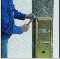
I.9 Otvory v tvárnici překryt kylem paty komína ze soupravy krytu paty komína.
