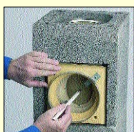
3.3 Na vložku osazenou nasucho přiložit napojovací díl a označit střed budoucího otvoru.
