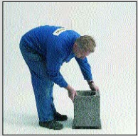
I.5 V další tvárnici vyřezat přes celou její výšku ve stěně otvor o šířce 16 cm.
