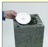
2.1 Na vložku s čerstvě naneseným Rotempem položit montážní kryt vložek.
