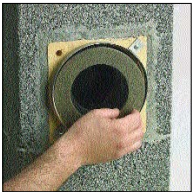
A.2 Na gumový adaptér osadit řídicí kroužek.
