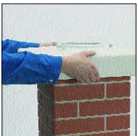
E.6 Osadit lehkou přivěrací krycí desku (pokud není součástí prefabrikovaného pláště) a dále postupovat podle bodů a obrázků 5.4 - 5.8.
