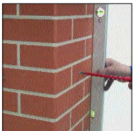
E.5 Osadit prefabrikovaný plášť z vláknitého betonu. Vyrovnat a pak zajistit aretačními šrouby.
