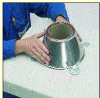
5.8 Navléknout na vložku kónus tak, aby dosedl na krycí desku.
