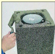
4.3 Na horní plochu tvárnice nanést tenkovrstvou maltu.
