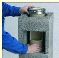
3.6 Vložku osadit a začíst vyhlazovačem spar spoj vložek.
