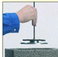
4.5 S pomocí magnetu (přiloženého) na vyhlazovači spar vyčistit zevnitř komína montážní kryt vložek.
