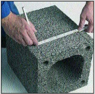
I.6 Ověřenou tvárnici osadit do maltového lože na soklové desce, nanést na horní plochu tenkovrstvou maltu.
