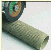
5.6 Na vložku odměřte délku. Délku měřte od hladkého konce vložky, část s hrdem odřízněte úhlovou bruskou.
