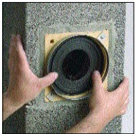
A.1 Do napojovacího dílu zasunout gumový adaptér. Pro usnadnění práce slouží mazací pasta.
