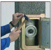
C.2 Na tvárnice osadit komínová dvířka.
