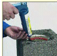
4.1 Do držáky profilované vložky nanést bohatě spárovací hmotu Rotempa.
