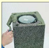
2.2 Na horní plochu tvárnice nanést spachtěl tenkovrstvou maltou.
