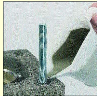
5.2 Armovací kanálky s vložkou výtěžně zalit zvládkovou maltou. Výtěž by měla být v kanálku vycentrována, aby se zvládka rovnoměrně dostala až ke koncům výtěžně.
