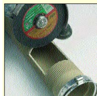
3.5 Úhlovou bruskou vyřezat do vložky otvor.
