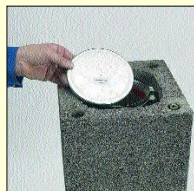
4.2 Osadit montážní kryt vložek na vložku s naneseným Rotempem.
