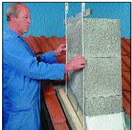
E.1 KOMÍNOVÝ PLÁŠŤ - Podle obrázku odměřit délky pro úpravu prefabrikovaného komínového pláště podle sklonu střechy. Před tím musí být komín oplechovaný!
