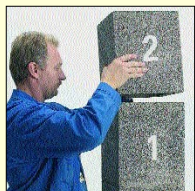
4.4 Do maltového lože osadit tvárnici a pak ještě jednu.
