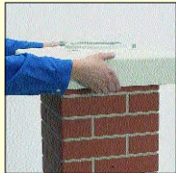
5.3 Krycí přivěrací lehká deska nebo plášť z vláknitého betonu s již připevněnou přivěrací krycí deskou se nasazují na tyče výtěžně, do maltového lože.
