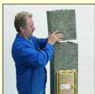
2.3 Do maltového lože osadit tvárnici.
