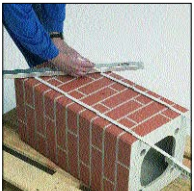
E.2 Na prefabrikovaný komínový plášť přenést naměřené délky. Podrobný postup viz dílčí návod.
