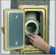
I.10 Do keramické paty komína osadit kroužek na vyrovnání tlaku ze soupravy Multi.
